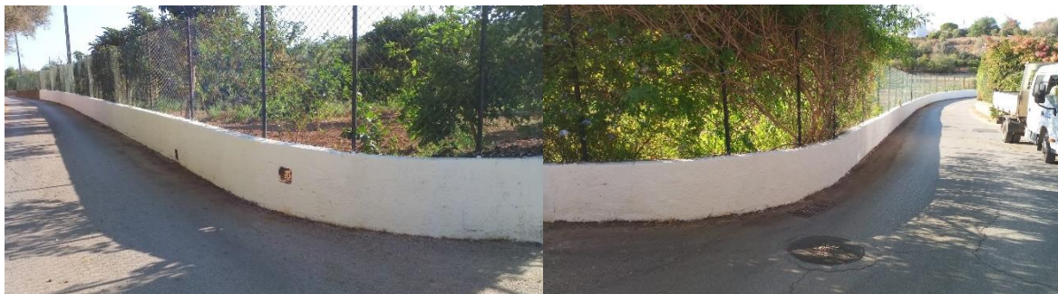
Limpeza de estrada do Vale das Hortas.
