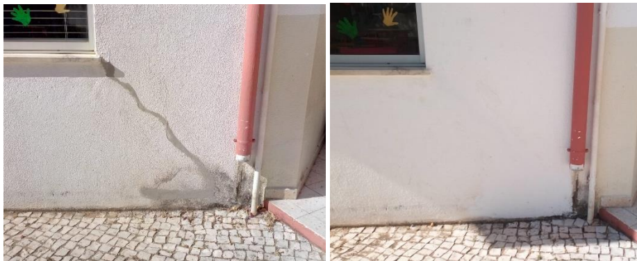
Antes de Depois – Conservações no Jardim de Infância de Alvor.
