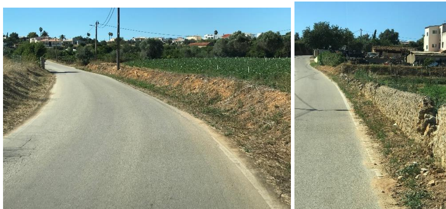
Limpeza de valas e bermas na Estrada do Barranco.
