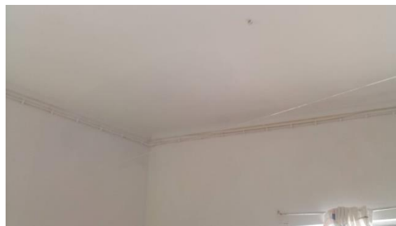
Antes de Depois – Conservações na EB1 de Alvor.
